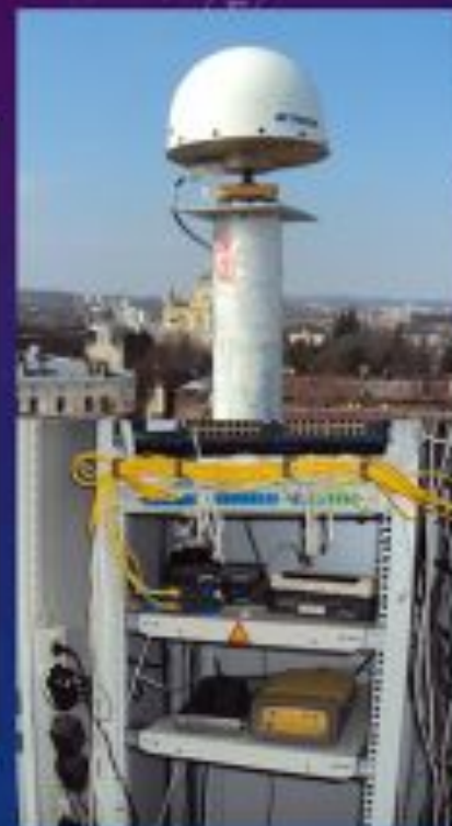
1 ГНСС приймачі TPS NET-G3A 1 GNSS ГНСС антени TPSCR.G5 TPSH
